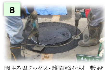
固まる君ミックス・路面強化材 敷設
