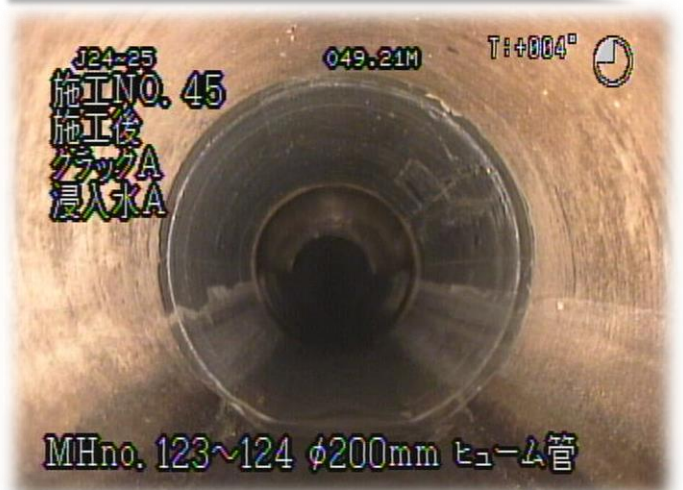
補修後 (EPR 工法による補修工事)
