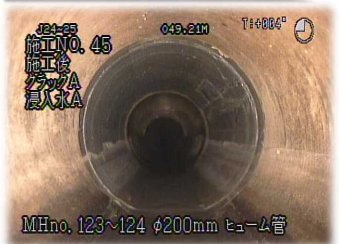
補修後 (EPR 工法による補修工事)
